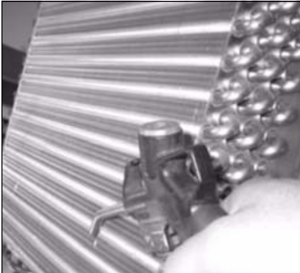
Imagen 31: Aplicar aire a presión en el registro del intercambiador de calor y el espacio del compresor
