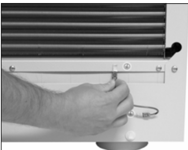
Imagen 26: Desconectar el cable de puesta a tierra
