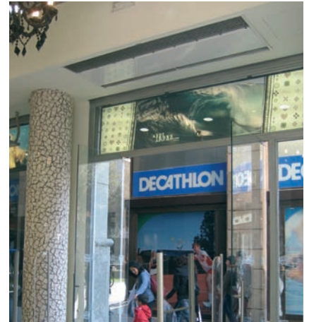
Windbox Empotrable Concebida para integración en falso techo
