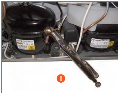
Figura 7: Colocación de una pinza pinche en un tubo de proceso
