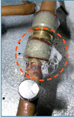
Figura 23a: Ejemplo de una conexión con fugas (ver las burbujas)
