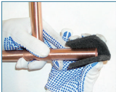
Figura 4: Limpieza de las superficies
