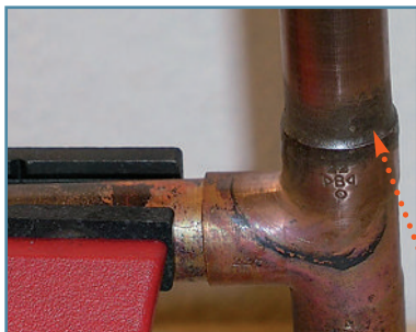
Figura 11: Vista detallada del relleno
