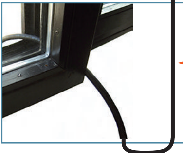
Figura 11: Recuperación de refrigerante a base de HC con una bomba de vacío y una línea de ventilación
