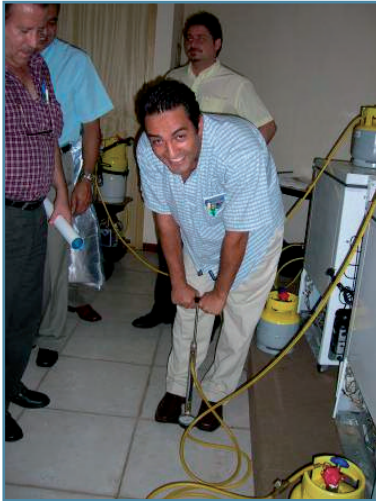
Figura 25: Conexión de una bomba manual de recuperación
