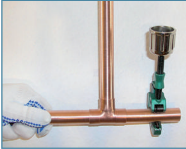
Figura 1: Corte del tubo
