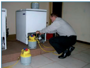
Figura 23: Colocación de un cilindro de recuperación
