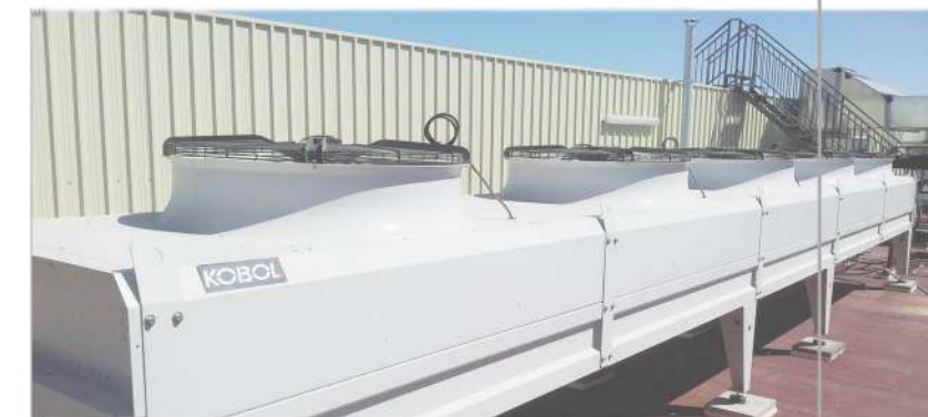
CAH - Tipo 1. con 5 ventiladores. CAH - Type 1. with 5 fans.
